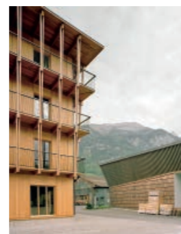
1 Urbach Tower, Remstal Gartenschau 2019 Foto ICD Universität Stuttgart 2 Seilingerinhart Architekten, Bürohaus Küng, Alpnach Foto Rasmus Norlander
